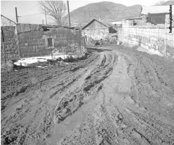
Straßen aus Dreck und zerfallene Häuser – seit dem Erdbeben 1988 wurde kaum etwas in Dschadschur erneuert. Die wirtschaftliche Lage ist schlecht, die Dorfbewohner leben in ärmlichen Verhältnissen.
