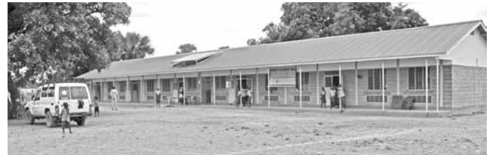
Wichtig ist auch das Lernumfeld: Mit dem Bau von Schulräumen tragen wir in Rumbek dazu bei, dass die Kinder nicht im Freien bei Wind und Wetter Unterricht haben.
