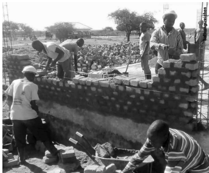
Das Fundament für das zentrale Behandlungsgebäude steht und die Ziegelwände wachsen jeden Tag. Erst wenn es errichtet ist, können Frauen im dortigen Kreißsaal medizinisch begleitet gebären.
