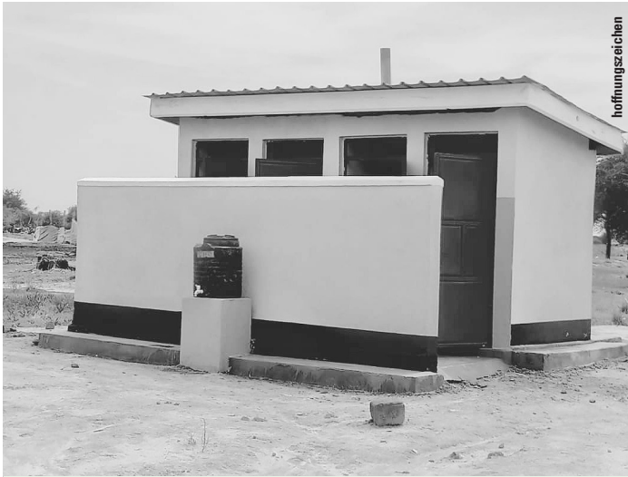
Neben den Schulgebäuden entstehen saubere, neue Latrinen und Waschräume. Zusätzlich werden den Kindern auch wichtige Hygieneregeln vermittelt.
