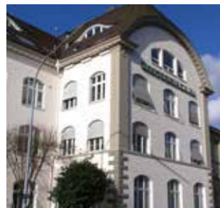
Ein großer Teil des Stiftungsvermögens wurde 2011 in ein Bürogebäude in Konstanz investiert. Hoffnungszeichen e.V. ist einer der Mieter.
