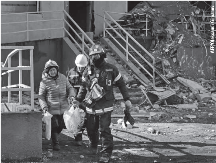
Grausamer Alltag in Odessa: Rettungskräfte helfen einer Bewohnerin, ihr durch einen Angriff zerstörtes Haus zu verlassen.
